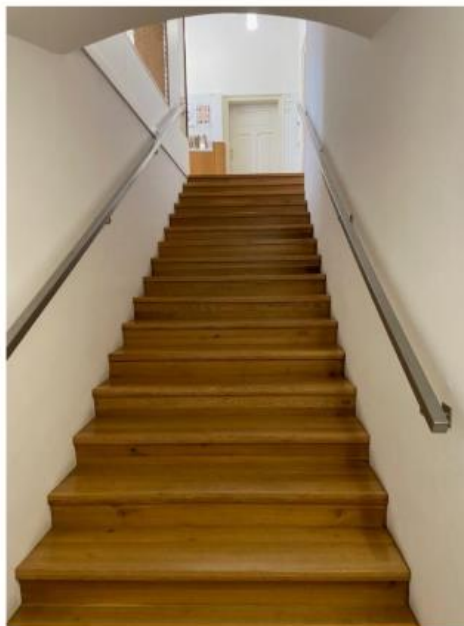
Foto 9: Pohled z podestv od WC směrem k pokladně
